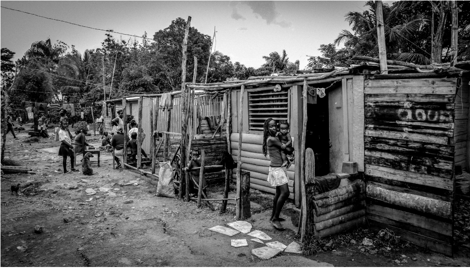
Figure 5 Exterior de una barraca construida con madera y chapa, destinada al alojamiento de los trabajadores y sus familias, como evidencia de las precarias condiciones habitacionales (fotografía del autor, República Dominicana, 2013).
