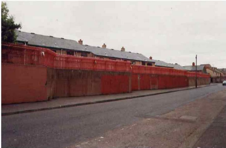
Figure 89 : Bryson Street, mur de sécurité (3 juin 2001)
